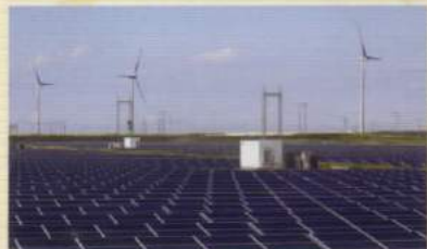
南相馬真野右田海老 太陽光発電所 万葉の里風力発電所
